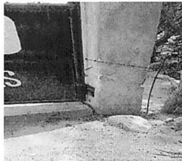
Foto 8: Sustrucción de columna para corrección de porton
