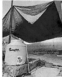
Foto 2: Cambio de tinaco de 1,100 lts, para mantener agua para los sanitarios.
