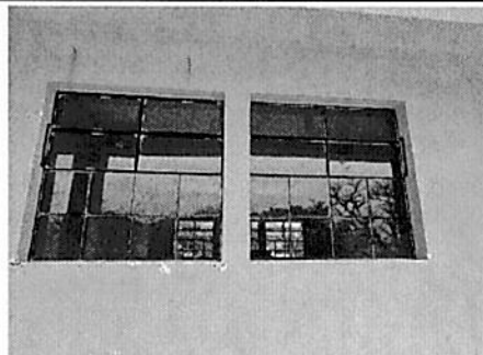
Foto 3: Colocación de balcones para resguardo del laboratorio de computación
